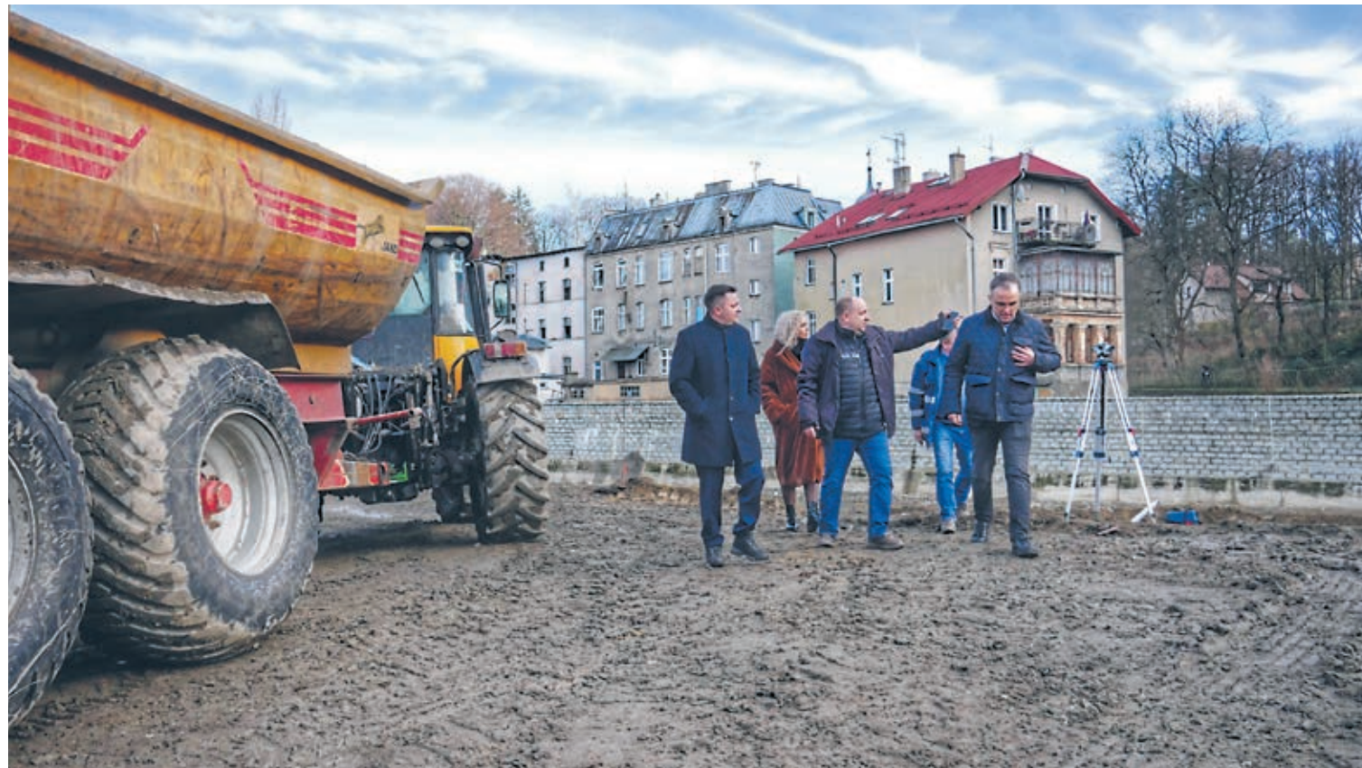
Wizytowany teren aktualnie prowadzonych prac przeciwpowodziowych na rzece Biała Głuchołaska
