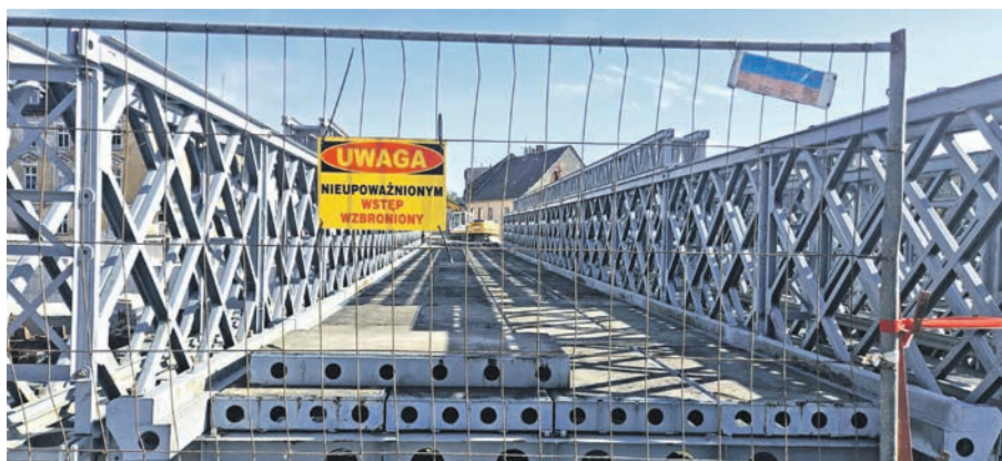
Obie nitki mostu już są przerzucone nad rzeką. Kończy się etap układania płyt jezdnych.
