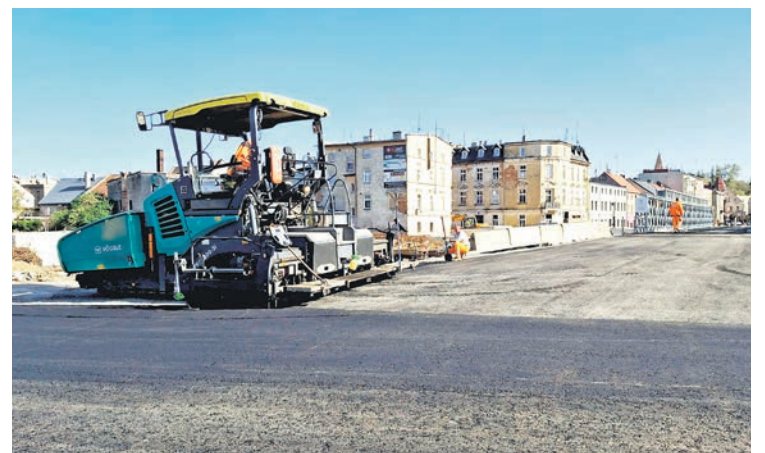
Układanie warstwy dojazdowej do mostu
